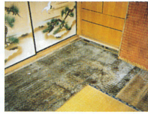
湿気により、腐朽菌が発生した床
