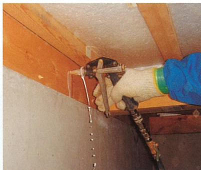
木部穿孔処理 (木栓処理)
